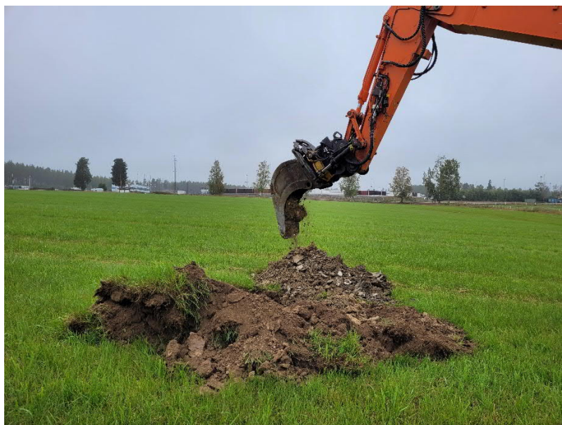
Figur 3. Provgrop 21T01PG. Foto: Tyréns 2021-09-10.
