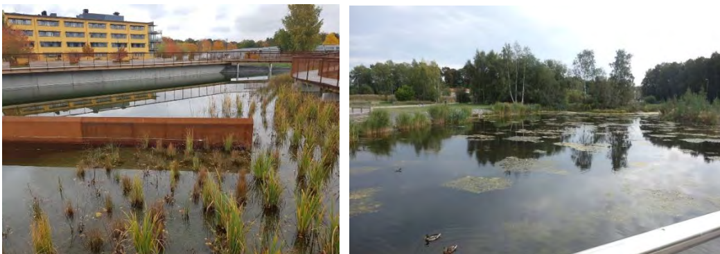
Två olika våta dammar, den vänstra har en vägg mellan olika delar av dammen för att öka retenstionstiden samt är djup i början för sedimentering för att sedan bli grundare (Våtmarkszon). Foto: Tyréns
