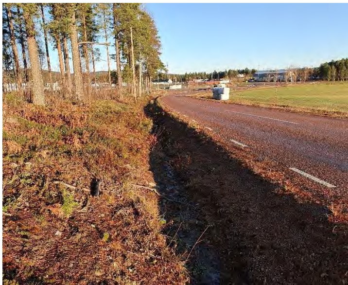
Figur 7. Dike väster om Frelugavägen.
