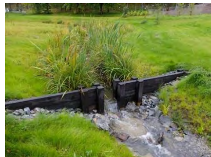
Till vänster: illustration av sektion genom ett typiskt svackdike. Källa: Stockholm vatten och avfall, 2017. Till höger: exempel på dämme i slutet av ett dike för att skapa större utjämningsvolym. Källa: VegTech.
