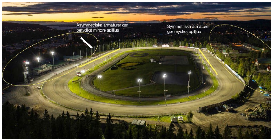
Figur 9. Referensbild från Östersundstravet där skillnaden mellan spilljus mot omgivningen av assymetriska och symmetriska armaturer på belysningsmaster åskådliggörs (Extol Lighting)
