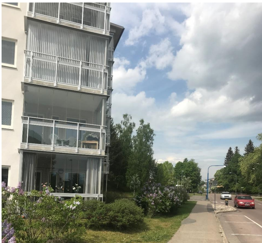
Bebyggelsen på Älgen 10 ligger cirka 2 meter från trottoarkanten med uterum/balkonger
