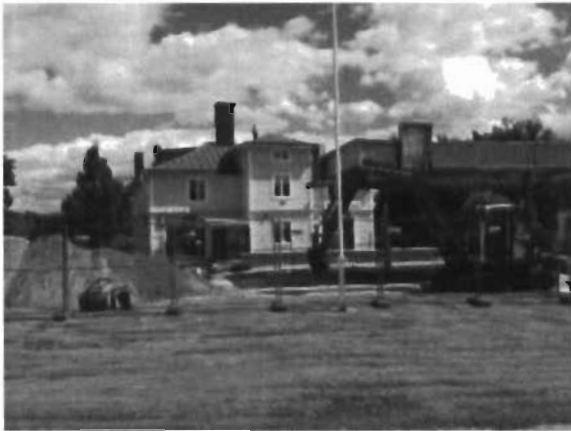
Bild 4: Schaktområde i närhet av fastighet.
