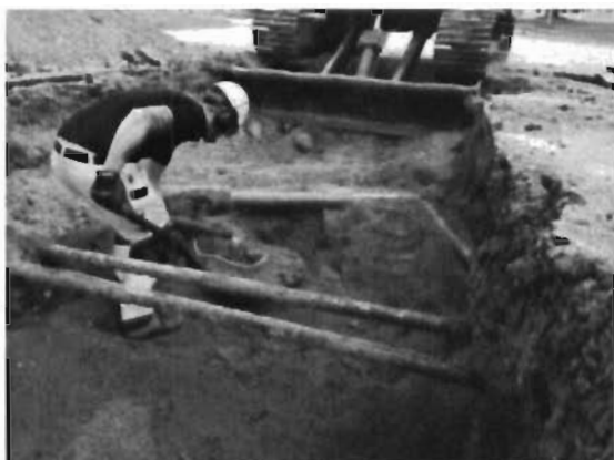
Bild 1: Framgrävning av manluckor
