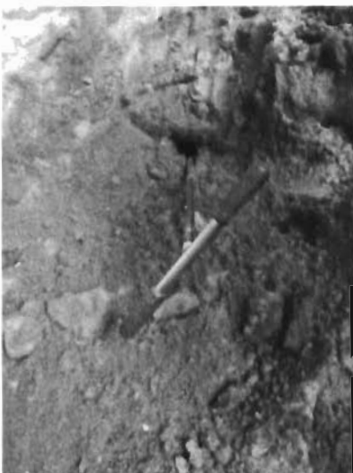
Bild 8: Skruvborr 2 meter in i schaktvägg mot fastighet.
