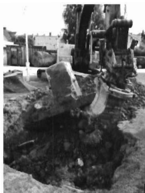
Bild 3: Upptagning av betongfundament på gräsyta.
