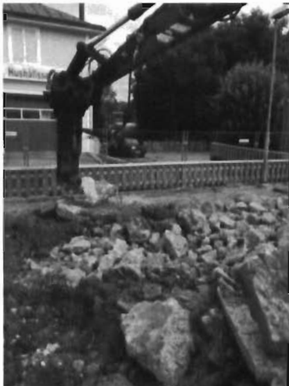
Bild 5: Betong som krossas och återanvänds som fyllnadsmaterial.
