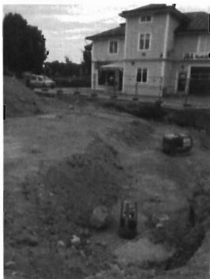
Bild 10: Återfyllnad
