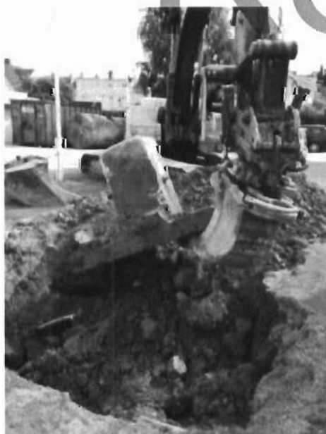
Bild 3: Upptagning av betongfundament på gräsyta.
