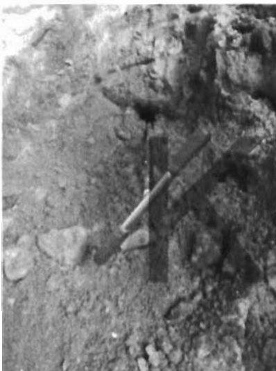
Bild 8: Skruvborr 2 meter in i schaktvägg mot fastighet.
