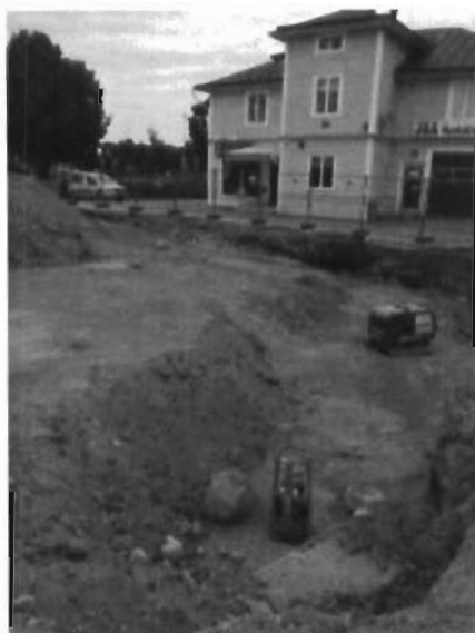
Bild 10: Återfyllnad
