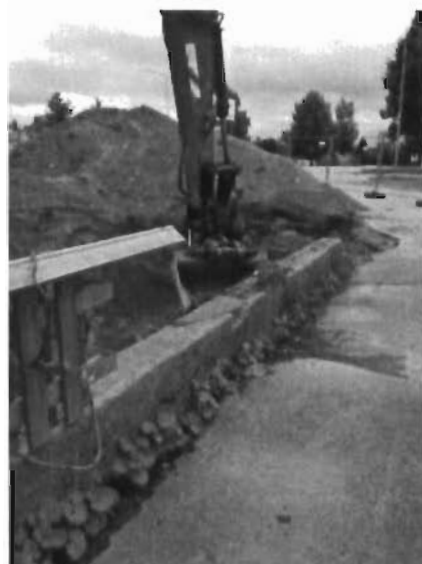
Bild 6: Mur som rivs.
