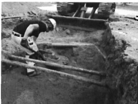
Bild 1: Framgrävning av manluckor
