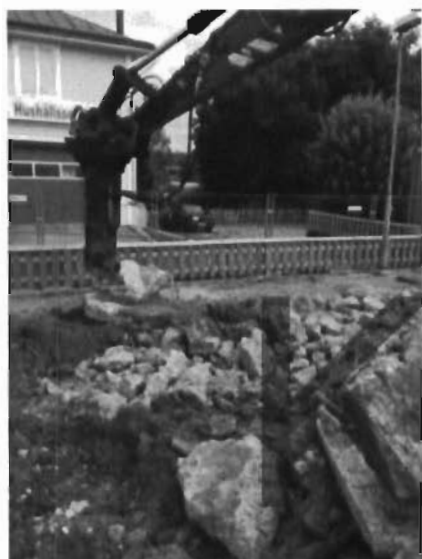
Bild 5: Betong som krossas och återanvänds som fyllnadsmaterial.
