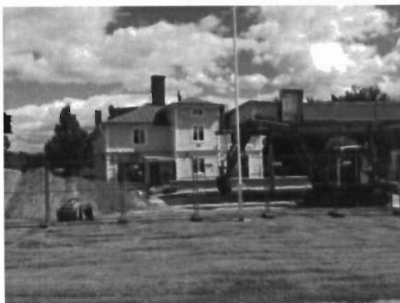
Bild 4: Schaktområde i närhet av fastighet.
